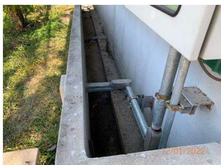
รูปที่ 3-15 รางระบายน้ำรอบอาคารพักขยะ
