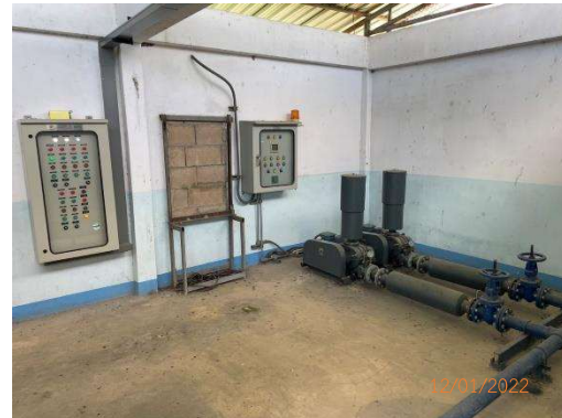
รูปที่ 3-1 บ่มเติมอากาศสำหรับระบบบำบัดน้ำเสีย
